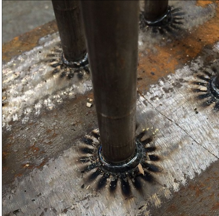
De ferrule werkt als een dam om het vloeibare metaal samen te houden wanneer de stiff in het smeltbad wordt gedrukt. Zo ontstaat er een mooie kraag omheen de lasnaad
