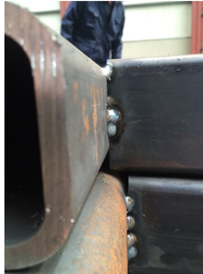
LASSEN van een LOOPBRUG
